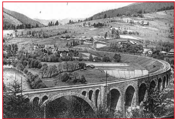
Rys. 12. Widok mostu przez Prut pod Worochtą – obiekt po odbudowie
