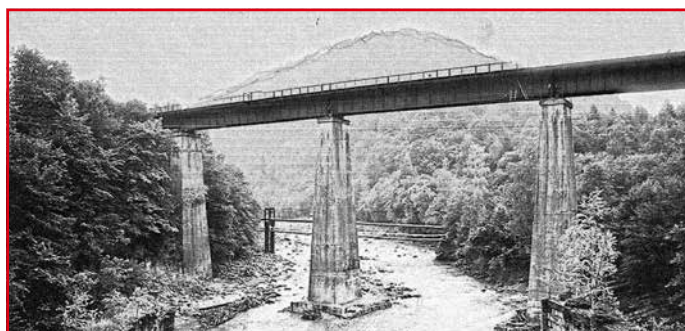
Rys. 7. Most o konstrukcji stalowej, a u dołu zburzone filary mostu łukowego na Prucie w Jaremczu
