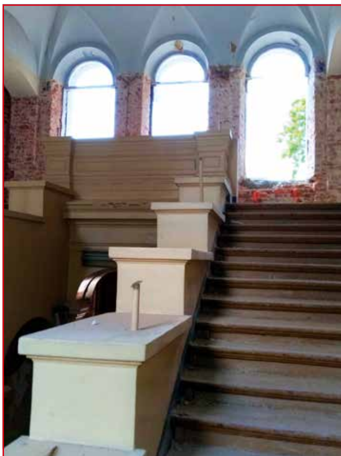
Klatka schodowa w trakcie remontu
