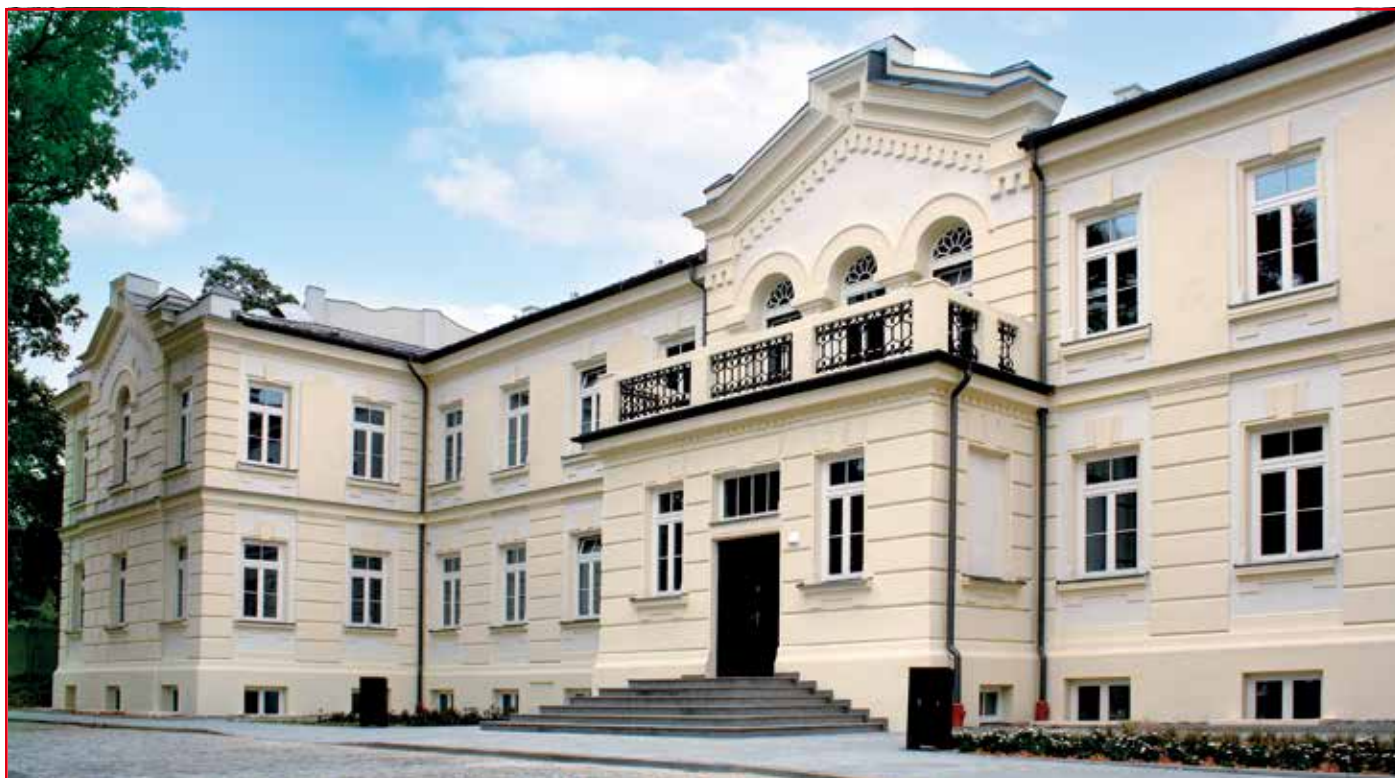
Elewacja po remoncie
