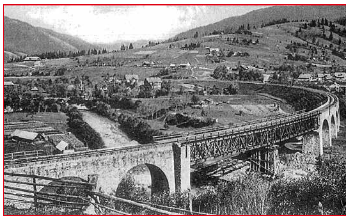
Rys. 11. Widok mostu przez Prut pod Worochtą – obiekt prowizorycznie naprawiony po zniszczeniach z I wojny światowej
