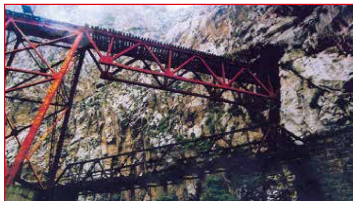
Rys. 2. Dwa tunele połączone mostami, to najtrudniejszy technicznie odcinek trasy
