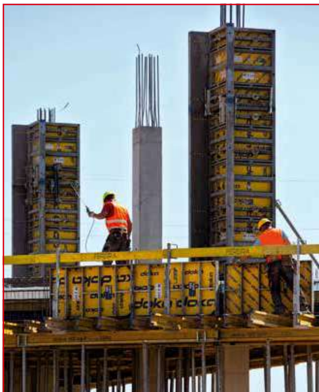
Utrudnieniem w trakcie procesu inwestycyjnego może być konieczność zmiany kierownika budowy
