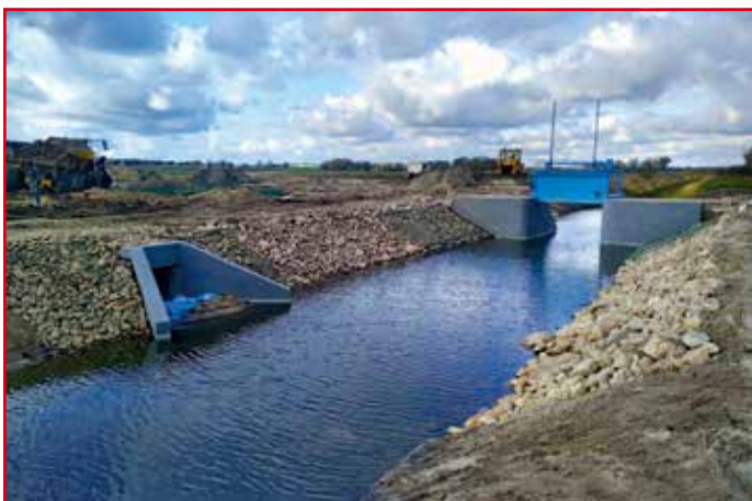
Fot. 6. Jaz żelbetowy na rzece Czapelka z ujęciem wody do zbiornika retencyjnego
