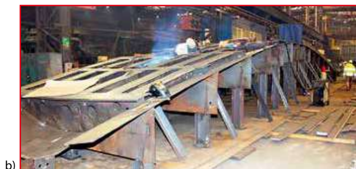
Rys. 7. Próbnny montaż kładki w Hucie Pokój w Rudzie Śląskiej (27.11.2019 r.): a) łuk dolny; b) łuk górny
