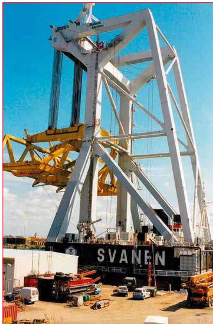
Rys. 6. Żuraw SVANEN – na placu budowy
