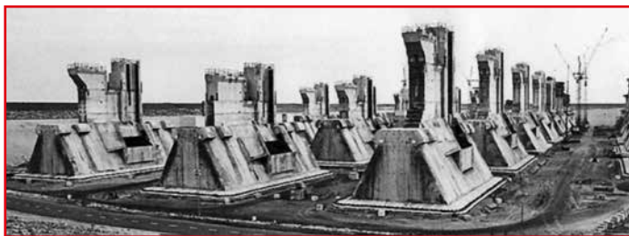
Rys. 5. Filary zapory po wykonaniu przygotowane do transportu
