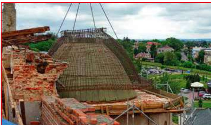
Montaż kopuły w kwietniu 2018 r.
