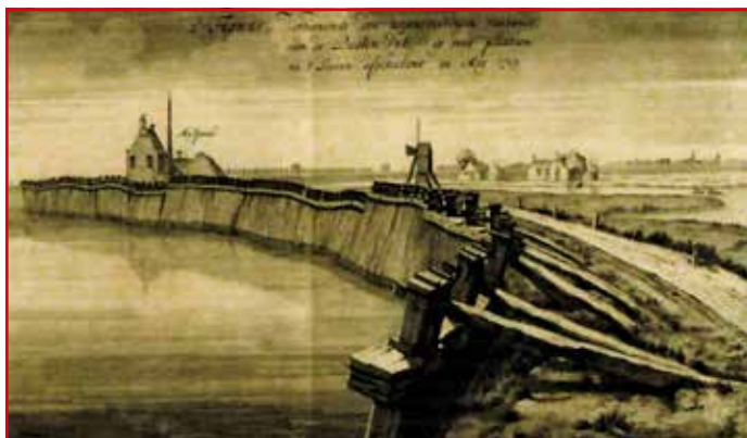
Rys. 1. Zabezpieczenie skarp wałów ochronnych palami drewnianymi
