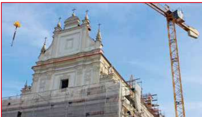
Widok na elewację ze zdobieniami. 2019 r.
