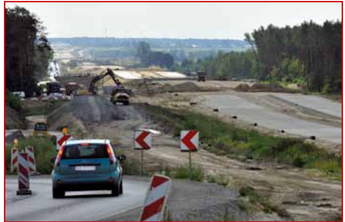
Budowa drogi S17
