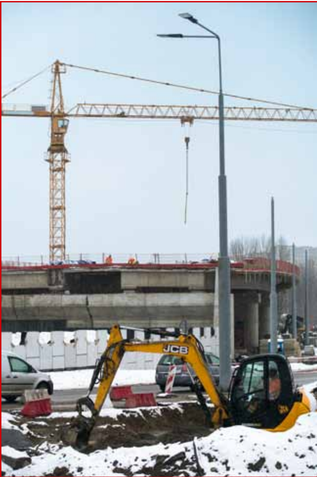
Przebudowa skrzyżowania ul. Krochmalnej z ul. Diamentową w Lublinie
