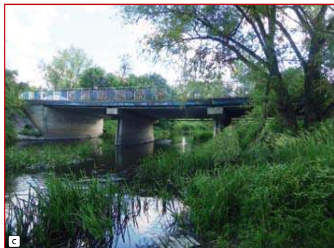
Rys. 2. Otoczenie młyna: a) elewacja południowa po rewitalizacji, b) zachodnia elewacja bez rewitalizujących tynków, c) nowy most żelbetowy
