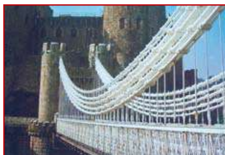
Fot. 2. Most w Conwy nad rzeką Conwy
