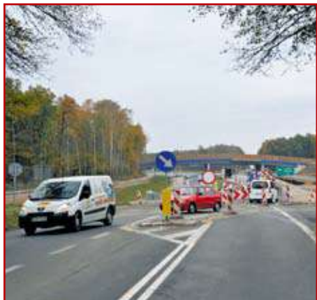
Pierwsze samochody na budowanej S19
