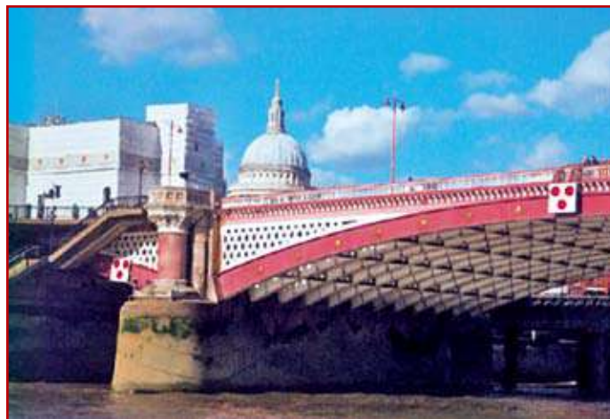
Fot. 5. Most Blackfriars. Po przebudowie w latach 1860–1910. Stan obecny.
