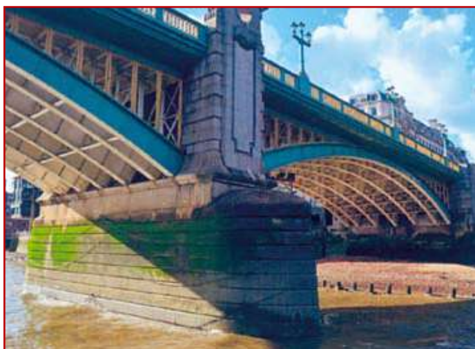
Fot. 7. Most Southwark. Wybudowany w roku 1921. Stan obecny.
