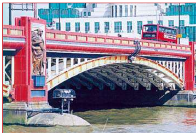
Fot. 8. Vauxhall Bridge. Przekazany do ruchu w 1906 roku. Stan obecny.
