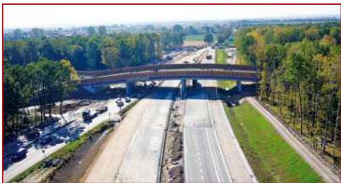
Budowa obiektu PZ z lotu ptaka
