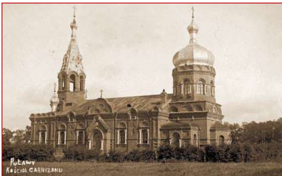
Fot.1. Cerkiew prawosławna wybudowana dla wojsk rosyjskich została wzniesiona w stylu bizantyjsko-ruskim, z ceglanyimi gzymsami kordonowymi stanowiącymi horyzontalne podziały elewacji. Gzymsy wieńczące istnieją w formie kroksztynek. Widok około 1910 r.
