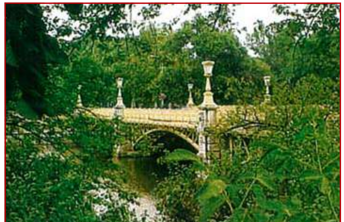
Kładka łukowa zaprojektowana przez inż. Szilárd Zielińskiego (stan obecny). Rok budowy 1896.
