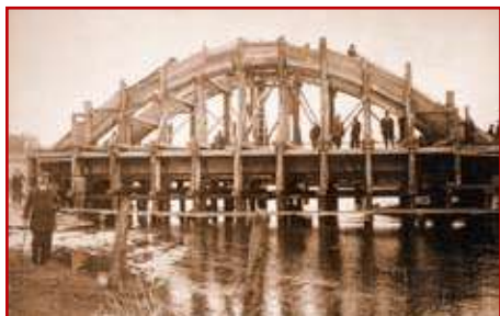
Zdj. 2a. Most na rzece Białej Ładzie w Biłgoraju w czasie budowy
