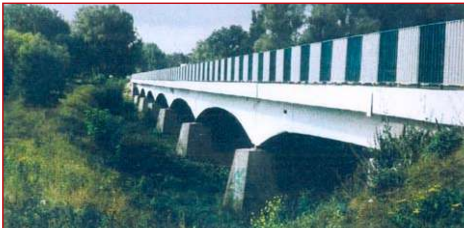
Zdj. 4. Most na rzece Wieprz w Trawnikach
