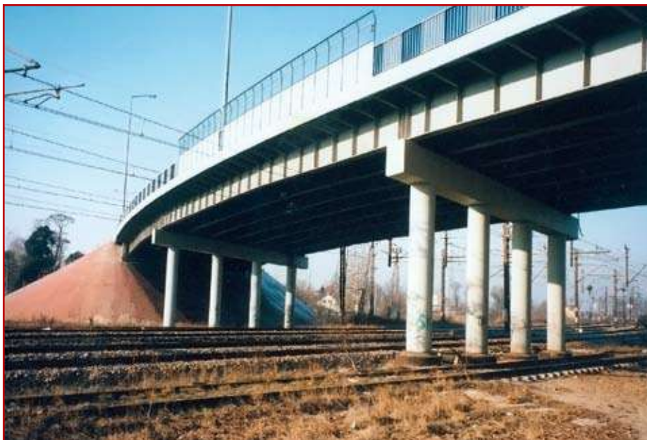
Zdj. 8. Wiadukt nad linią kolejową Warszawa - Lublin w Dęblinie
