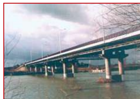
Zdj. 7. Most na rzece San w Krzeszowie
