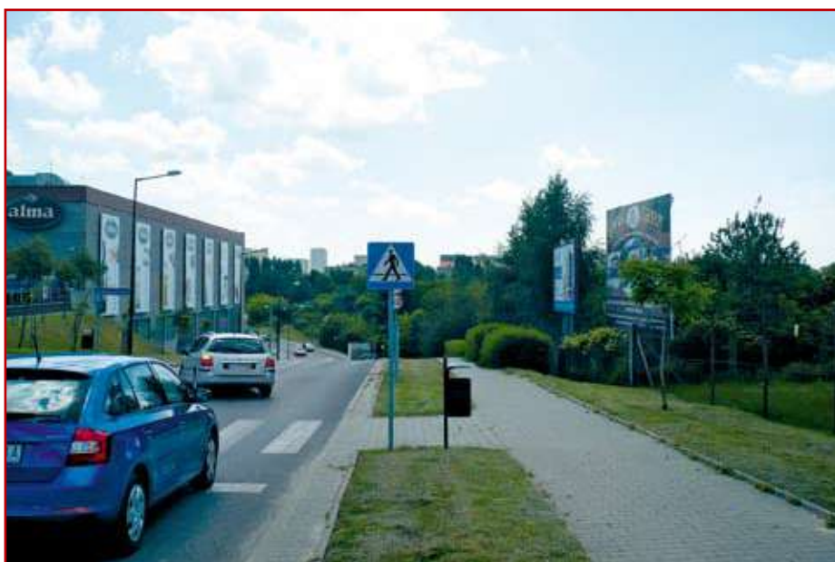
Ul. Bursaki – znikające samochody w zagłębieniu niwelety przed skrzyżowaniem
