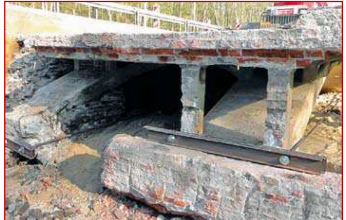
Zdj.2. Widok na most po rozbiórce przyczółków od strony Tomaszowa Lubelskiego
