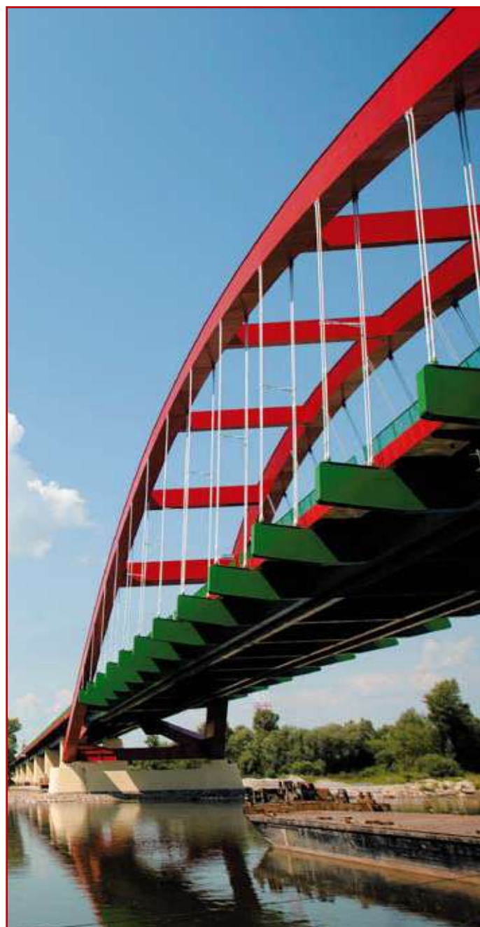
Dobrze zabezpieczony przed korozją most może służyć wiele lat Fot. Radosław Pasterski
