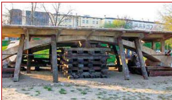
Zdj.4. Elementy mostu w tymczasowym miejscu na terenach zielonych Politechniki Lubelskiej
