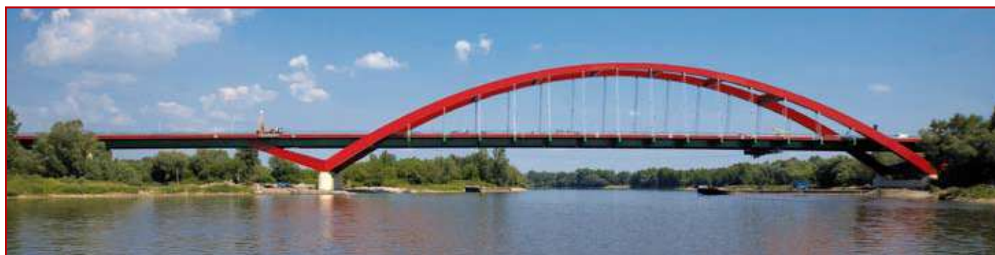
Most przez rzekę Wisłę w Puławach im. Jana Pawła II Fot. Radosław Pasternski
