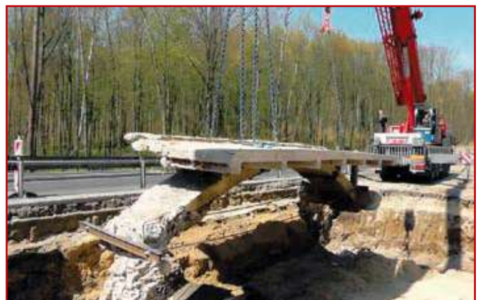
Zdj.3. Załadunek elementów obiektu na platformy
