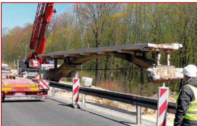
Zdj.3. Załadunek elementów obiektu na platformy
