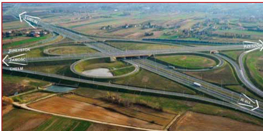
Węzeł Lublin-Sławinek (Dąbrowica)
