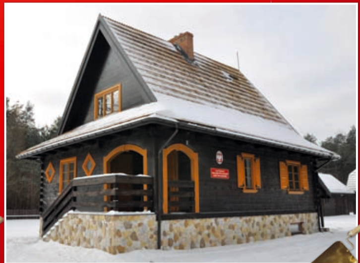
Budynek mieszkalny – Leśniczówka Gościniec w Makoszce, gm. Dębowa Kłoda
