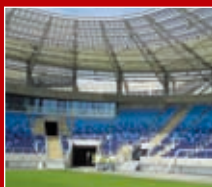
Stadion miejski Arena Lublin w Lublinie Fot. UM Lublin
