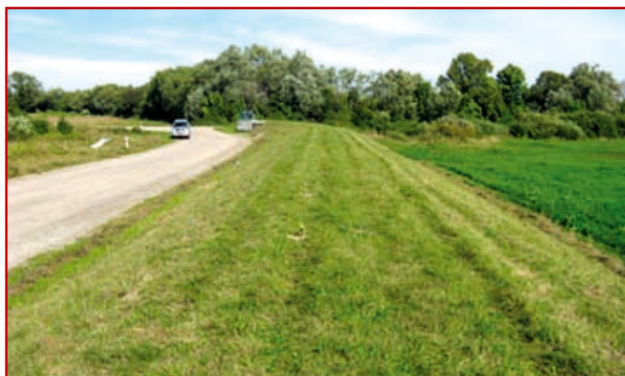
Fot. nr 6 – Korpus wału przeciwpowodziowego – Aleja Marzeń
