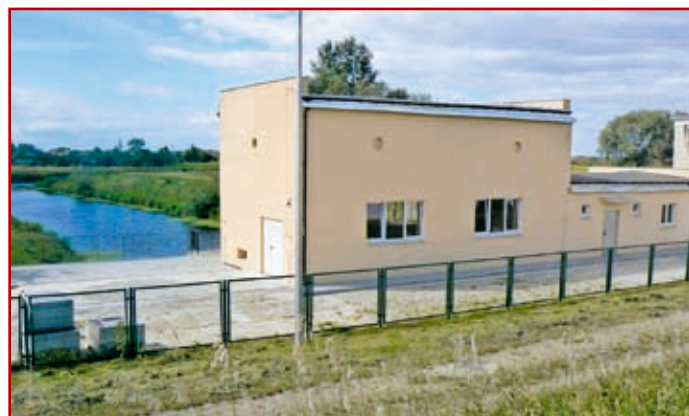
Fot. nr 7 – Zmodernizowana pompownia w Terespolu
