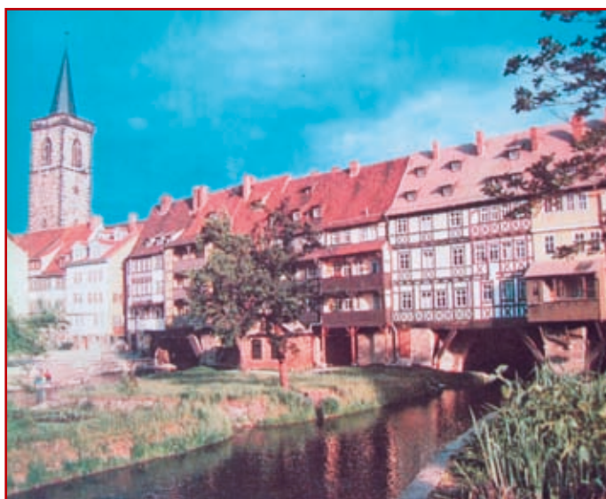
Zdj. 6. Most mieszkalny Kramerbrücke na rzece Gera w Erfurcie - stan obecny
