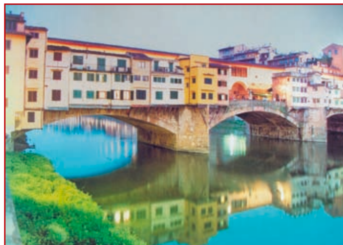
Zdj. 4. Most Ponte Vecchio Florencja – stan obecny
