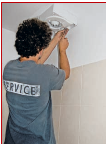
Podczas remontu dokonano wymiany instalacji wentylacyjnej
