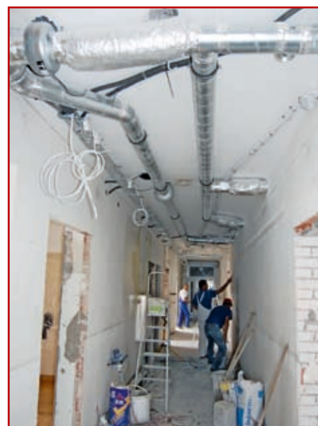
W październiku pomieszczenia szkoleniowe znajdujące się na parterze budynku mają być oddane do użytku
