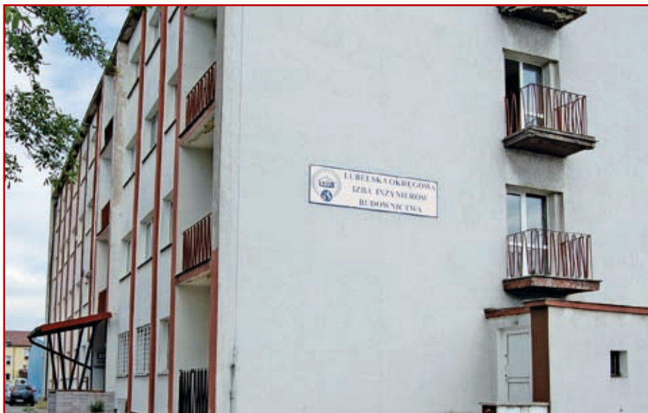
Tak obecnie wygląda siedziba LOiIB, która niedługo ma zmienić elewację
