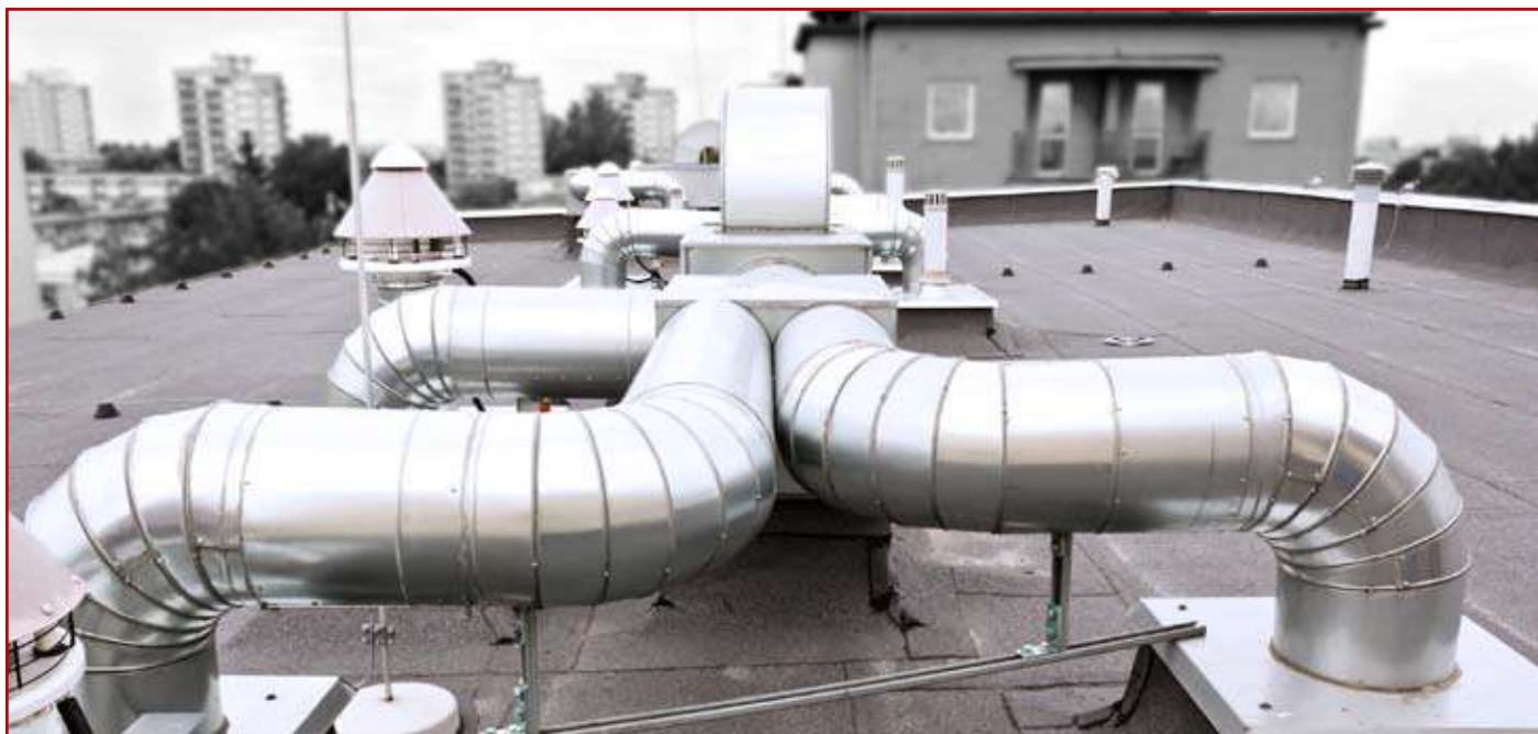
System wentylacji mechanicznej, higrosterowanej oparty o wentylatory wyciągowe VEC, kratki wyciągowe, higrosterowane BXL oraz nawiewniki okienne, higrosterowane EHA
