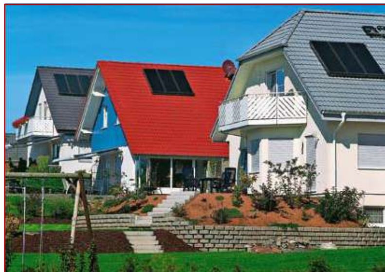
1. Wyroby budowlane zastosowane w realizowanych obiektach powinny być dokładnie sprawdzone
