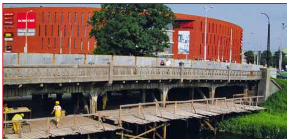
Zdj. 3. Wzmocnianie belek głównych mostu na ścinanie (2011 r.)
