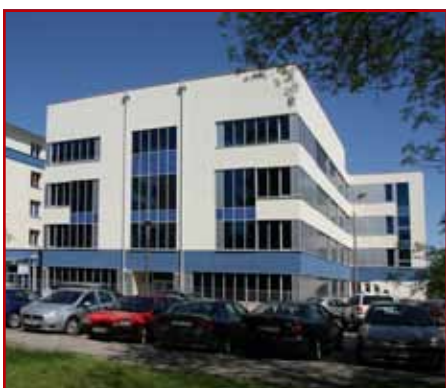
Centrum Nowych Technologii Wyższej Szkoły Ekonomii i Innowacji przy ul. Mełgiewskiej w Lublinie
