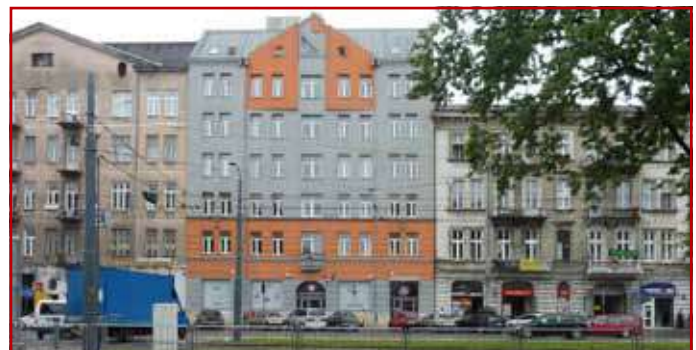
Rozbudowa i modernizacja siedziby Głównego Inspektoratu Sanitarnego przy ul. Targowej 65 w Warszawie, wraz z pierwszym wyposażeniem
