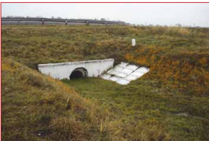
Budowla melioracyjna na obiekcie p.n.: Słotwyński
