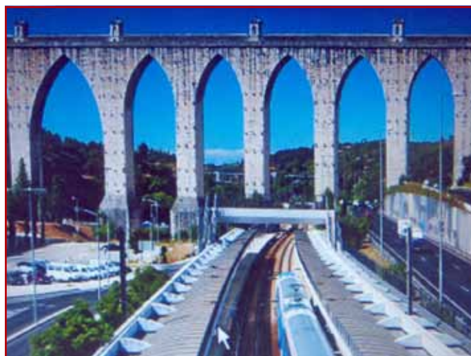
Rys. 5. Akwedukt Livras (Lizbona). Rok budowy 1731-1748. Stan obecny
