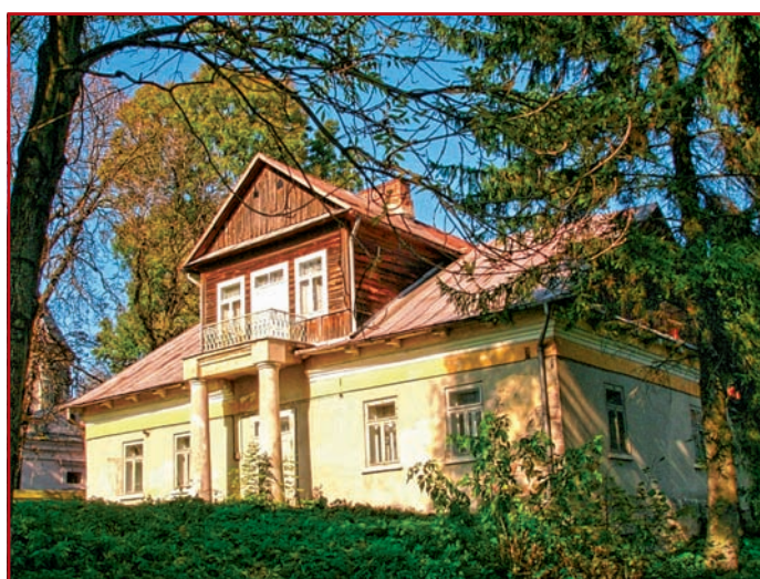
Rys. 1. Elewacja południowo-wschodnia starej plebanii w Wojsławicach (2010 roku)
