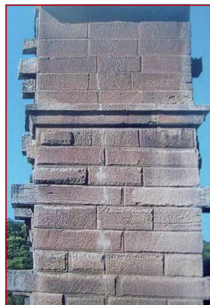
3. Układ ciosów w sklepieniach Pont du Gard
