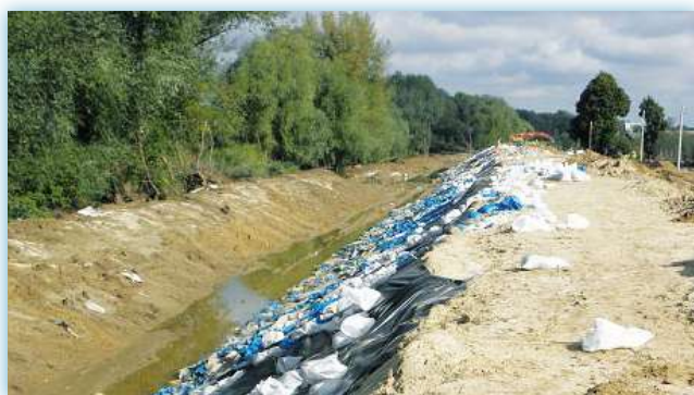
Wał opaskowy w budowie w m. Zastów Polanowski
