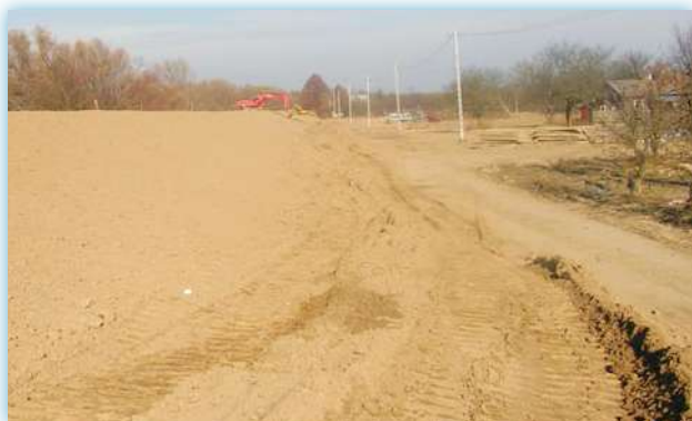
Odbudowywany wał w m. Zastów Polanowski
