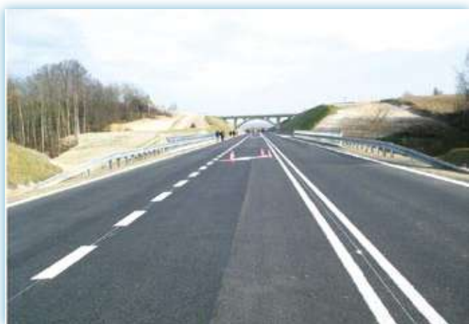
Obiekt nr IV i wiadukt łukowy nr V
