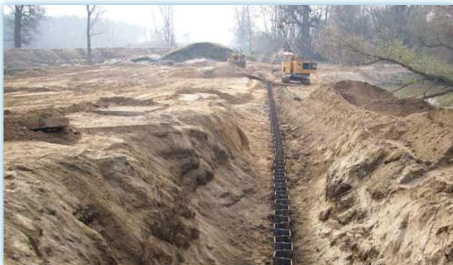
Zabijanie ścianki szczelnej w m. Popów
