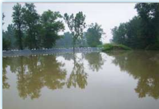
Wykonany wał opaskowy w m. Popów
