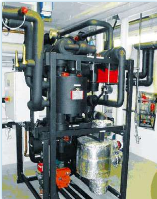
Rys. 2. Widok agregatu absorpcyjnego agregatu chłodniczego bez obudowy
