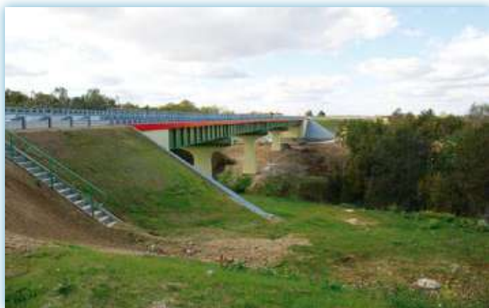
Widok ogólny estakady – obiekt nr III
