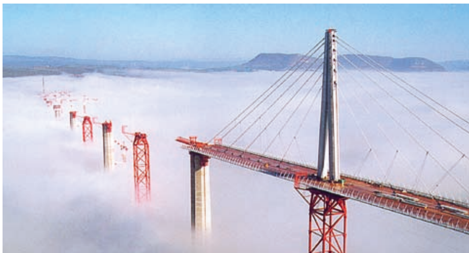
Wiadukt Millau w chmurach w trakcie realizacji
