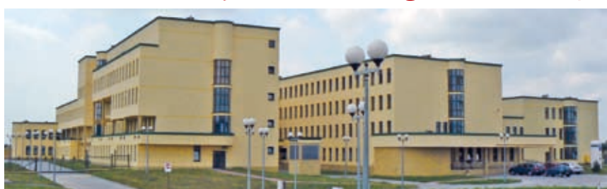
Widok obiektów szpitalnych z boku
