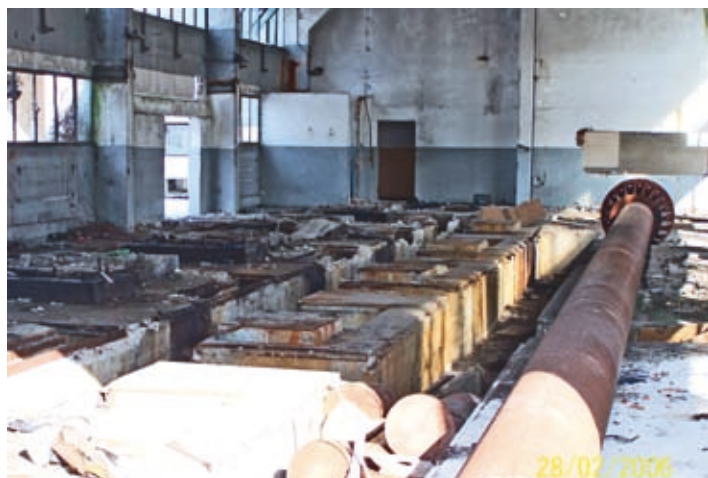
Zniszczone wnętrze byłej fabryki
