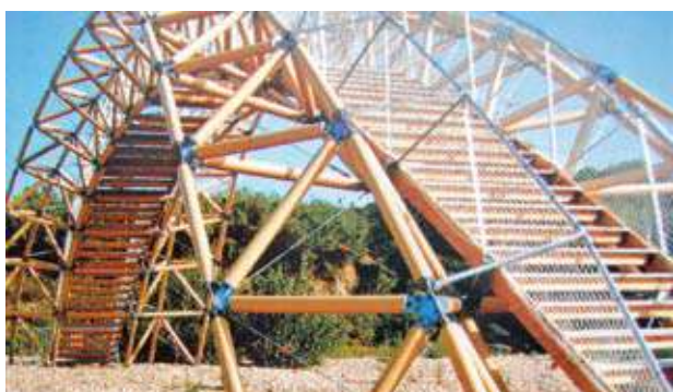
zdj. 8 Kładka z kartonu obok akweduktu Pont du Gard – Francja
