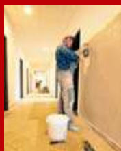
Na okładce: Robotnicy remontują- cy nową siedzibę LOIIB przy ulicy Bursaki 19 w Lublinie
