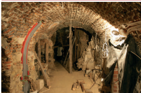
Prace w piwnicach trwają
