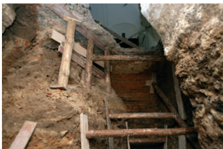
Zabezpieczenia przez osunięciem
