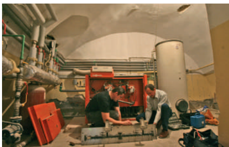
Montaż instalacji grzewczej
