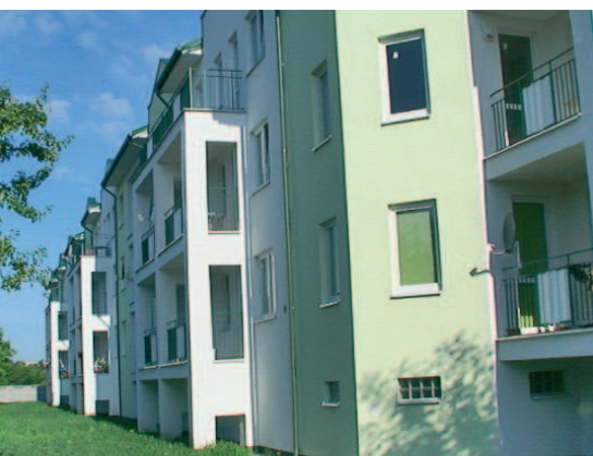
Budynek mieszkalny wielorodzinny przy ul. Płk. Wł. Muzyki w Chełmie
