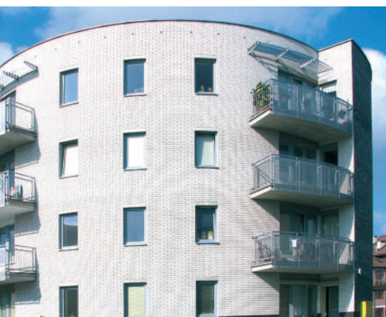
Budynek mieszkalny nr 9 w zespole zabudowy mieszkaniowej TBS przy ul. Cisowej w Świdniku
