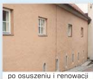
po osuszeniu i renowacji
