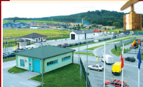
Drogowe przejście graniczne w Hrebennem po rozbudowie
