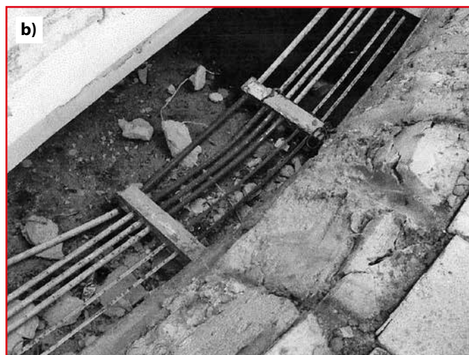
Rys. 8. a) odchylenie się balustrad na wsporniku chodnika; b) oderwanie się wspornika chodnika wraz z balustradą mostu
