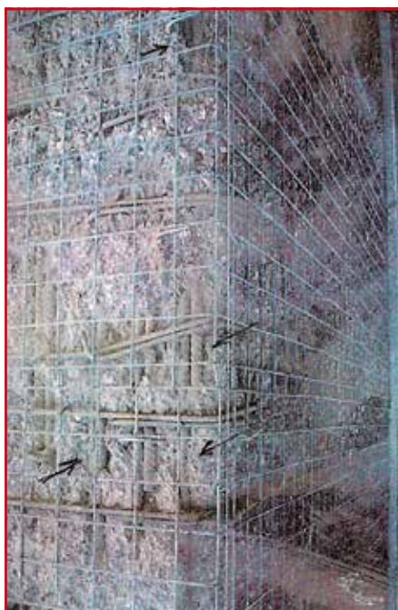
Rys. 13. a) usunięta uszkodzona otulina; b) oczyszczone zbrojenie
