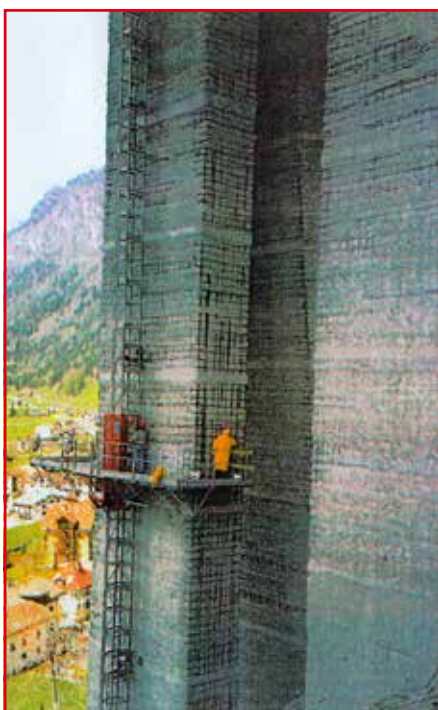
Rys. 14. Prace naprawcze na filarach o wysokości 80–90 m
