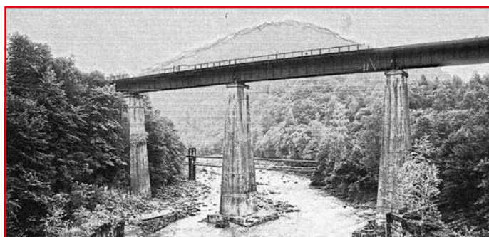
Rys. 7. Most o konstrukcji stalowej, a u dołu zburzone filary mostu łukowego na Prucie w Jaremczu
