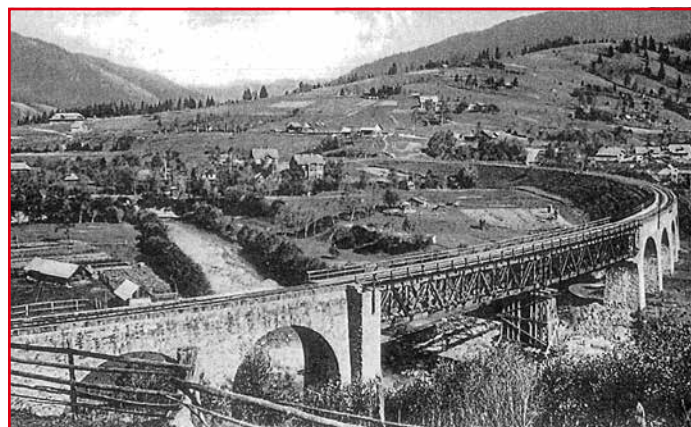
Rys. 11. Widok mostu przez Prut pod Worochtą – obiekt prowizorycznie naprawiony po zniszczeniach z I wojny światowej
