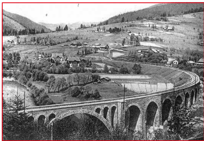
Rys. 12. Widok mostu przez Prut pod Worochtą – obiekt po odbudowie
