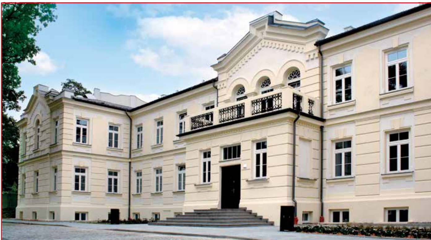
Elewacja po remoncie
