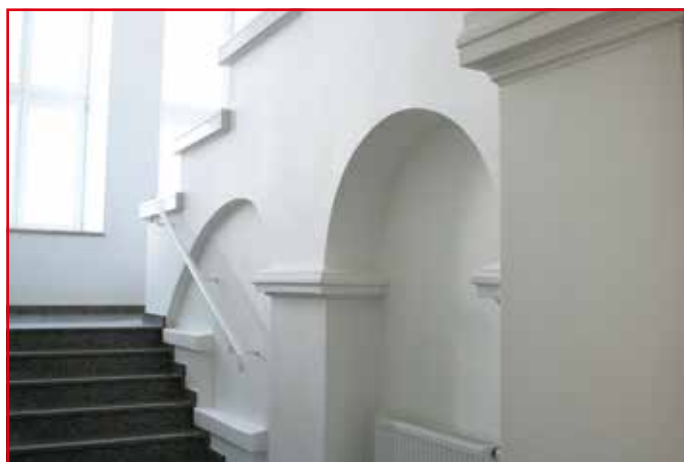
Klatka schodowa po remoncie
