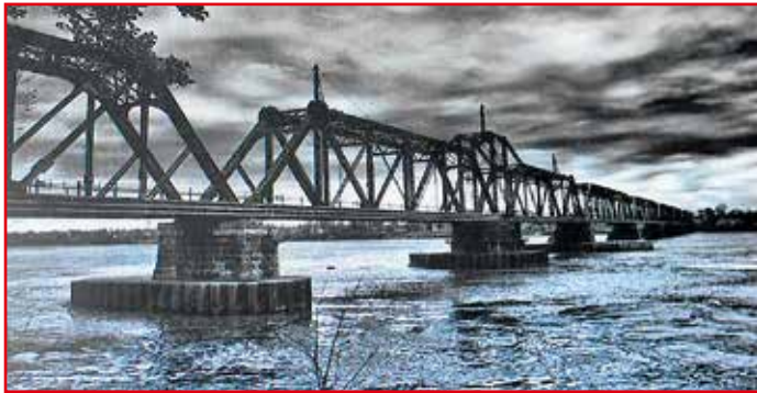
Rys. 6. Most stalowy nad rzeką Niagarą o długości 1100 m łączący Kanadę ze Stanami Zjednoczonymi
