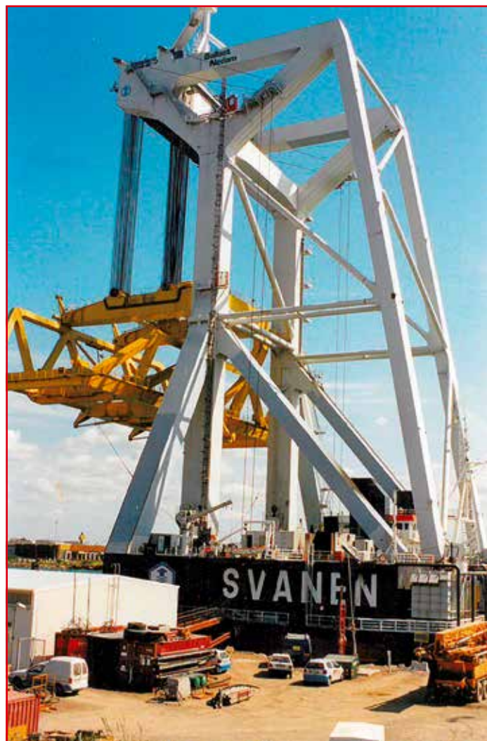
Rys. 6. Żuraw SVANEN – na placu budowy
