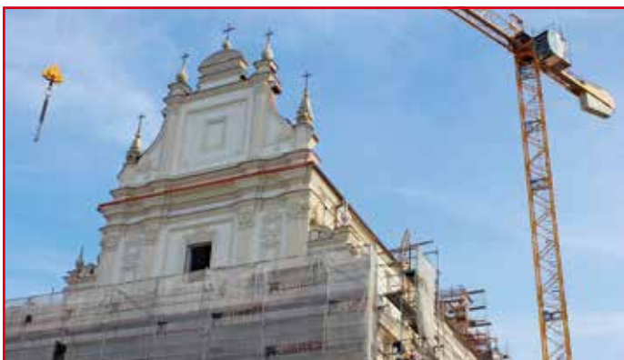
Widok na elewację ze zdobieniami. 2019 r.
