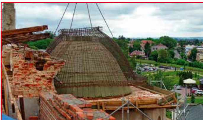
Montaż kopuły w kwietniu 2018 r.
