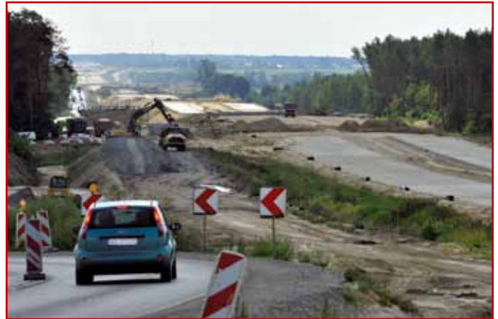
Budowa drogi S17
