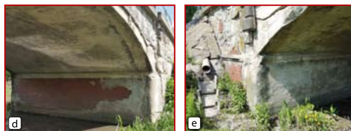
Rys. 6. Łuk Moniera: a) schemat łuku Moniera, b) wyodrębnienie łuku i przyczółka, c) wyodrębnienie wezgiłowia, d-e) dolna powierzchnia łuku
