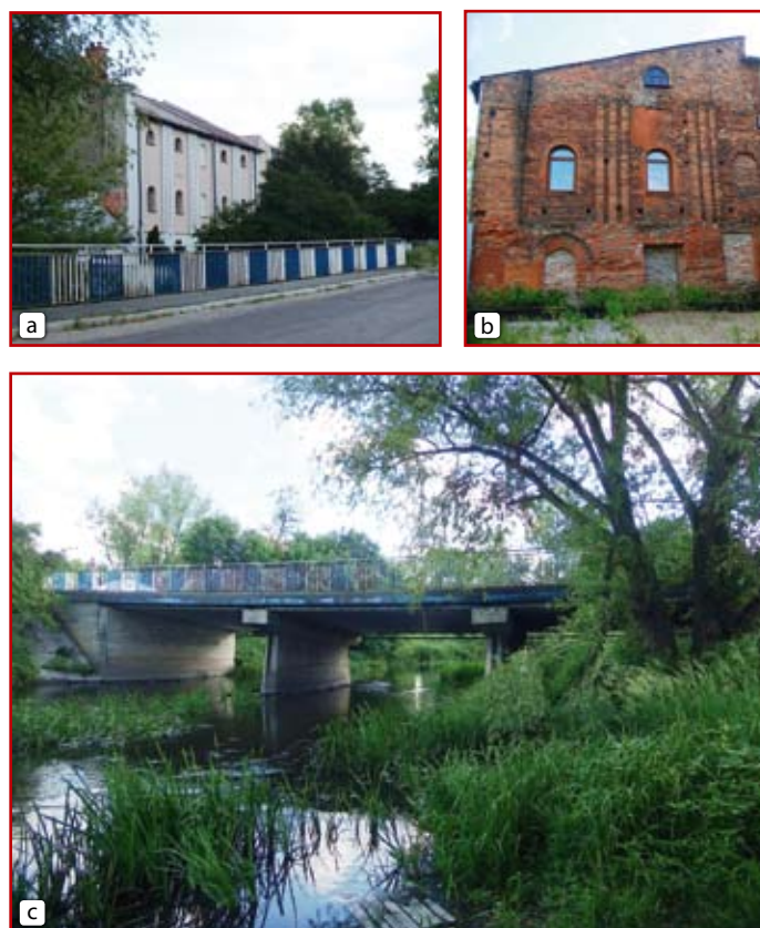
Rys. 2. Otoczenie młyna: a) elewacja południowa po rewitalizacji, b) zachodnia elewacja bez rewitalizujących tynków, c) nowy most żelbetowy
