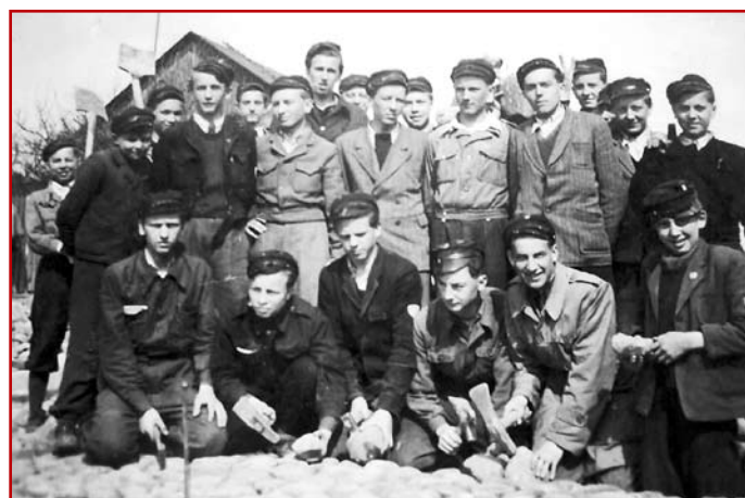
Rok 1949. Uczniowie Szkoły Budownictwa w Lublinie Wydziału Drogowego. Klasa III Gimnazjum. Remont ulicy Pawiej i układanie bruku w ramach zajęć praktycznych
