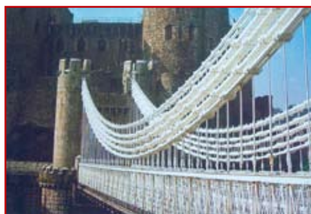
Fot. 2. Most w Conwy nad rzeką Conwy
