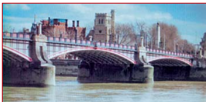
Fot. 6. Most Vauxhall Lambeth Bridge. Wybudowany w 1932 r. Stan obecny.
