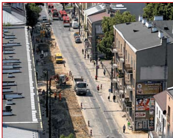
Przebudowa ul. Narutowicza. Widok z lotu ptaka
