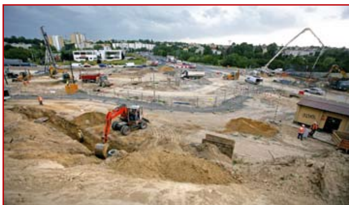
Prace prowadzone przy przebudowie ul. B. Ducha
