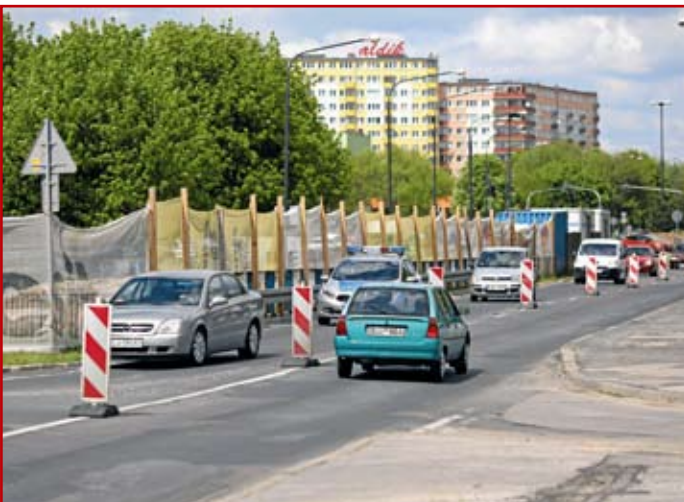
Remont w ciągu ul. Kompozytorów Polskich
