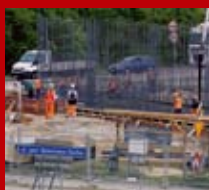
Przebudowa ul. gen. B. Ducha w Lublinie
