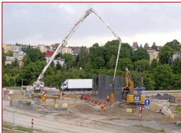
Przebudowa ul. B. Ducha
