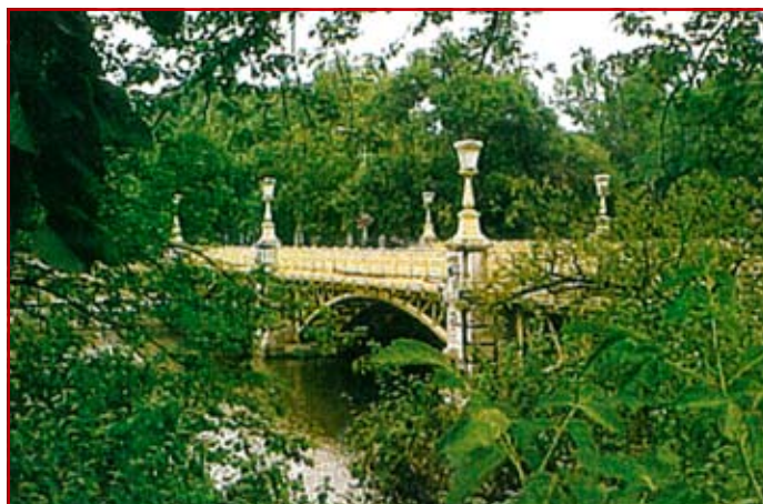
Kładka łukowa zaprojektowana przez inż. Szilárd Zielińskiego (stan obecny). Rok budowy 1896.
