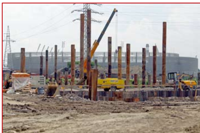
Ulica Muzyczna w przebudowie
