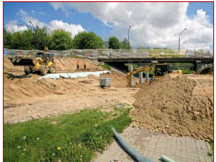
Prace w dzielnicy Czechów
