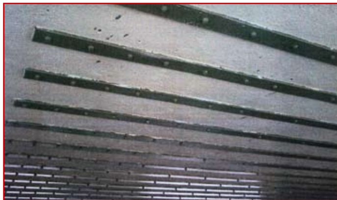
b. wzmocnienie sufitowej płyty pomostu
