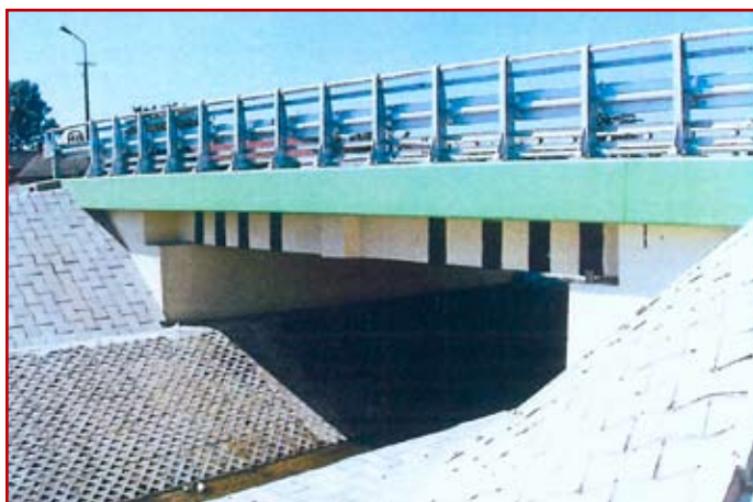
Fot. 7. Wzmocnienie prefabrykowanych dźwigarów głównych mostu taśmami z włókien węglowych
