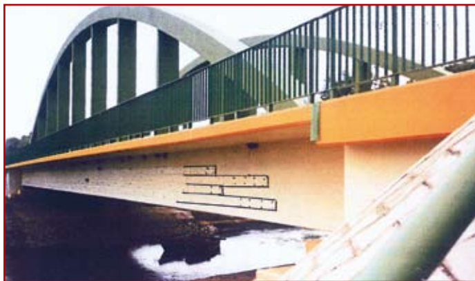
a. wzmocnienie bocznych powierzchni dźwigara
