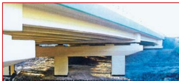
Fot. 2b. Po wykonaniu uciążlenia przęseł zmiana schematu statycznego
