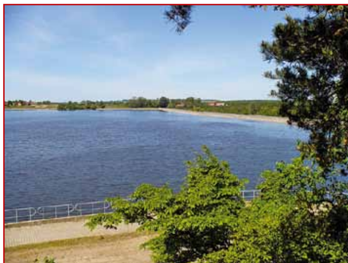
Fot. nr 3. Widok ogólny czaszy zbiornika w Nieliszu o pow. 888 ha i poj. 19,5 mln. m 3
