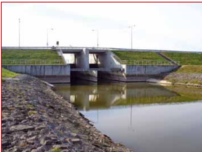
Fot. nr 4. Jaz zapory czołowej zbiornika głównego w Nieliszu o pow. 709 ha
