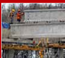
Budowa wiaduktu w Lublinie
