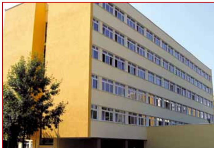
Wydział Budownictwa i Architektury Politechniki Lubelskiej w 2004 r.
