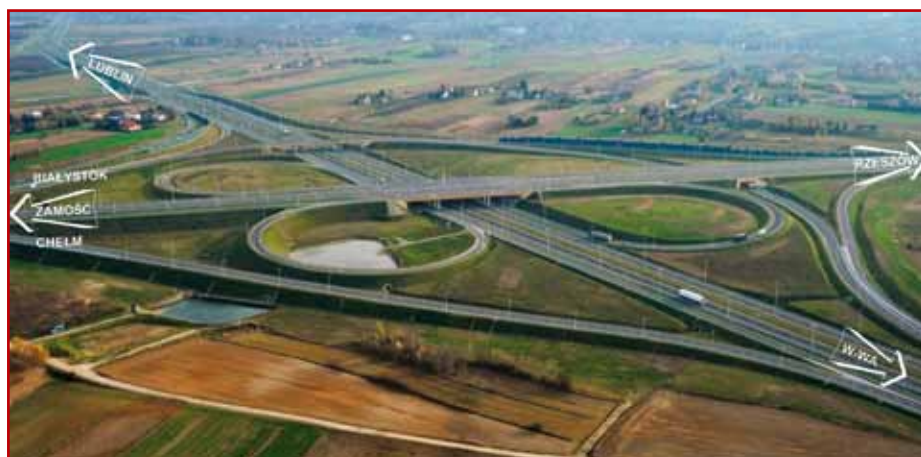
Węzeł Lublin-Sławinek (Dąbrowica)
