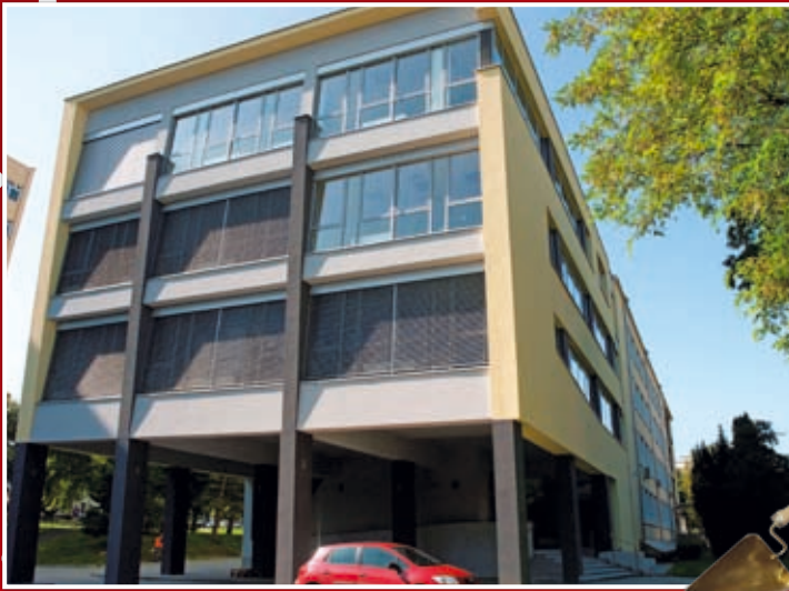
Rozbudowa budynku Wydziału Elektrotechniki i Informatyki Politechniki Lubelskiej przy ul. Nadbystrzyckiej 38A w Lublinie
