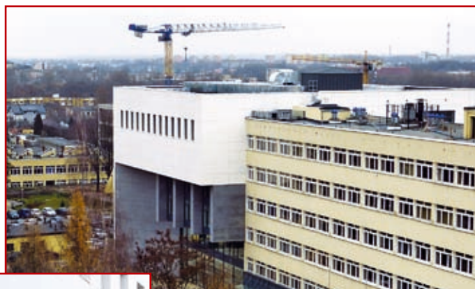
Widok na istniejącą i nowo wybudowaną część Wydziału Budownictwa i Architektury
