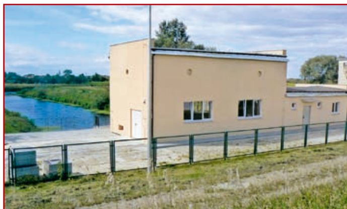
Fot. nr 7 – Zmodernizowana pompownia w Terespolu
