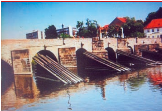
Zdj. 2. Jeleni most na rzece Otawa - stan istniejący
