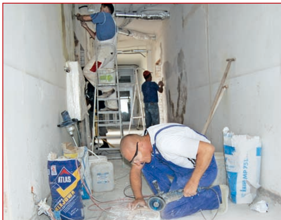
Pomimo wysokich temperatur tegorocznego lata, prace remontowe postępowały szybko i sprawnie
