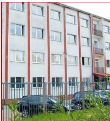
Budynek na zewnątrz też czeka remont...
